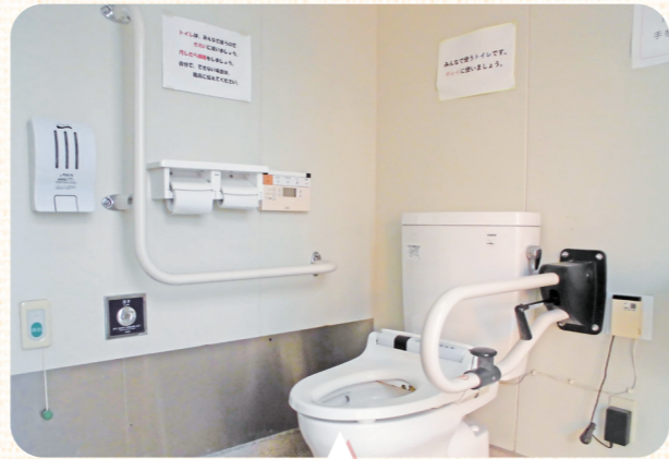
トイレに手すりを設置して移乗
