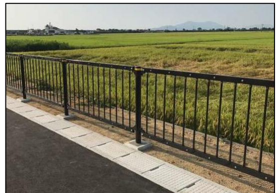
ほ場に設置されたセーフティフェンス
