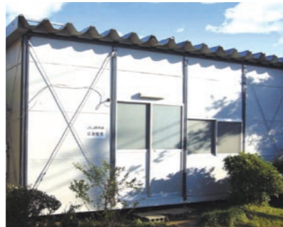
■JA共済仮設住宅貸与サービス 仮設住宅を8か月間無償でお貸しするサービスです。住宅だけでなくキッチン、トイレ、お風呂など暮らしに必要な生活用品をあらかじめ備えています。
